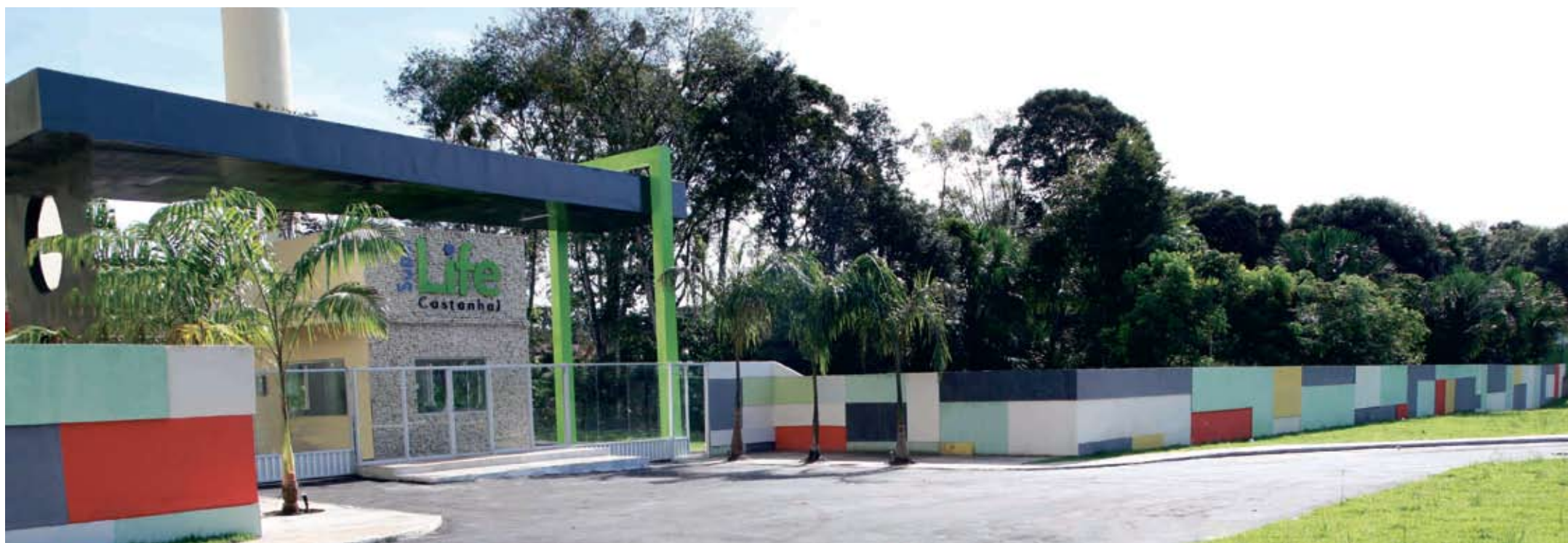
O Super Life, projeto da Building Construtora e Incorporadora, reúne conforto, segurança e mais de 20 itens de lazer. Entre os diferenciais do condomínio estão preço acessível, projeto inovador, grande área e contato com a natureza
